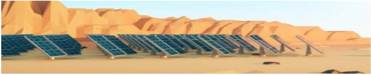
亿晶建议，组件不应安装运行在冰雹、雪、沙、灰尘、空气污染、烟尘等过多的区域。组件不要安装在存在腐蚀性物质（如盐、盐雾、盐水、化学活性蒸汽、酸雨、任何其他类型的腐蚀剂）的位置，这可能影响组件的安全和/或性能。
