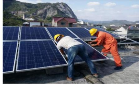
请勿试图拆解组件或取下组件上任何零件，如：铭牌等。请勿在组件的表面刷油漆或任何其他粘合剂。不要划伤组件边框的绝缘层（接地连接处除外），其可能导致边框腐蚀从而影响边框的强度。也不要不要在边框上钻孔，这可能会影响边框的强度，并加快边框腐蚀。
