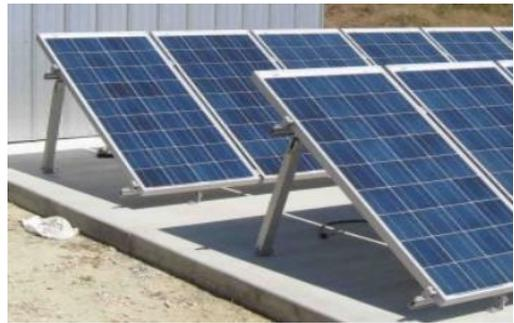
不建议将组件水平安放（0° 倾斜角），因为灰尘容易积聚，从而影响功率输出。亿晶建议组件安装倾斜角度至少为 9°，以便于灰尘被雨水冲走，且无需定期清洁，防止表面积水，避免组件表面长期积水而导致玻璃发霉影响组件的衰减。
